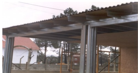
Figura 25 - Pormenores de execução do sistema LSF
