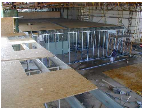
Figura 19 – Remodelação de instalações com execução de um novo piso
