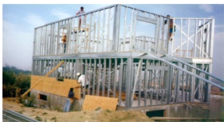
Figura 14 – Montagem da estrutura no sistema LSF
