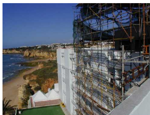
Figura 19 – Ampliação de instalações execução de um novo piso no sistema LSF
