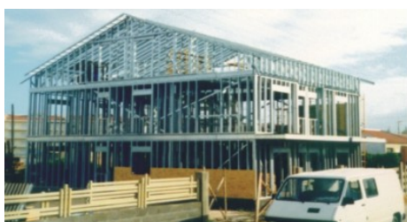
Figura 16 – Aspecto final da estrutura
