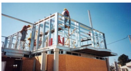
Figura 15 – Execução de pisos e de aberturas no sistema LSF
