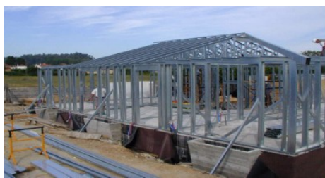
Figura 13 – Fundações e estrutura no sistema LSF
