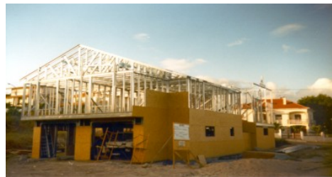
Figura 24 – Pormenores de execução do sistema LSF
