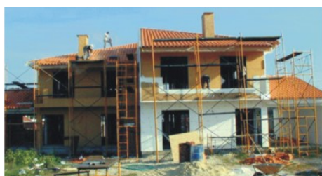
Figura 17 – Colocação do isolamento térmico sobre as placas de OSB
