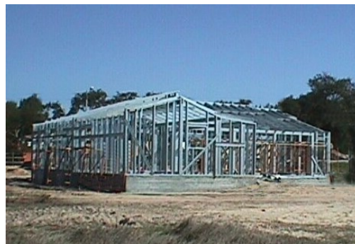
Figura 2 – Montagem da Estrutura LSF
