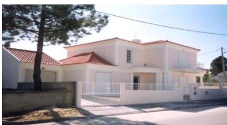
Figura 18 – Aspecto final da obra
