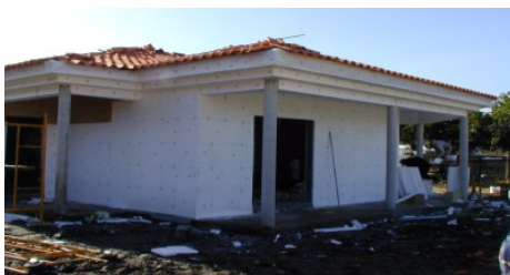
Figura 25 - Pormenores de execução do sistema LSF
