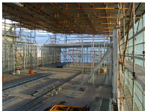
Figura 19 – Remodelação de instalações com execução de um novo piso
