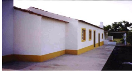
Figura 22 - Várias fases da construção
