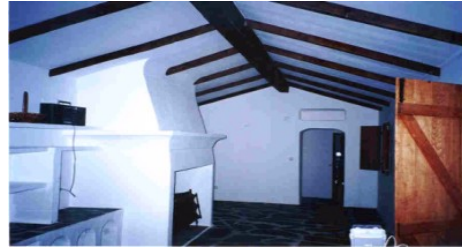
Figura 22 – Execução da cobertura
