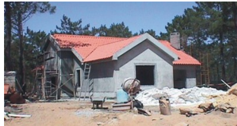
Figura 23 – Colocação de placas de OSB e do revestimento final
