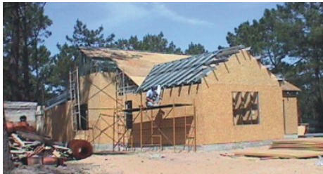
Figura 23 – Colocação de placas de OSB e do revestimento final
