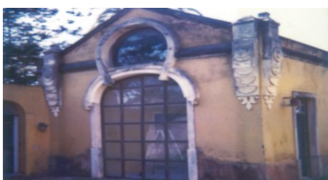
Figura 20 - Antes da intervenção de reabilitação
