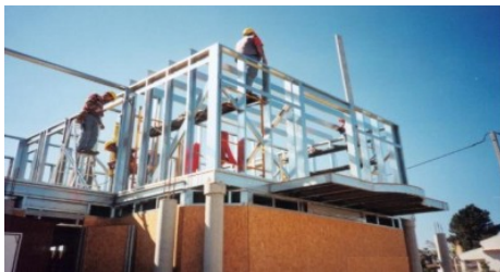
Figura 24 – Pormenores de execução do sistema LSF
