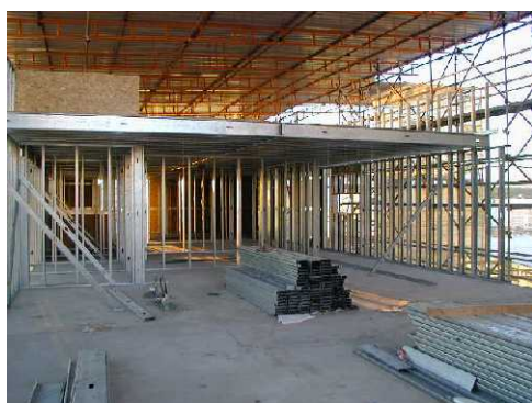
Figura 19 – Ampliação de instalações execução de um novo piso no sistema LSF
