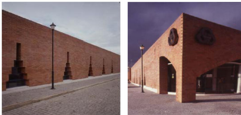
Figura 7- Caixa Geral de Depósitos – Avis – Vista do Alçado Principal e do semi-arco da entrada
