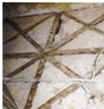
Figura 10 – Parede de escada em edifício pombalino
