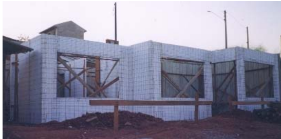
Figura 32 - Residência estruturada com o Painel Monolite, sem a necessidade de pilares e vigas, projecto desenvolvido para o Sistema Monolite, que otimiza prazo e gastos em estruturas de betão armado.
