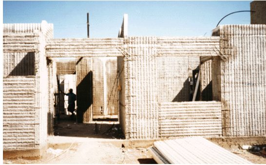
Figura 14 – Obra em fase de projecção da argamassa
