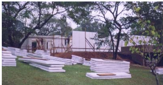
Figura 30 - Obra em fase de montagem: painéis modulares conforme o projecto de arquitectura, obra limpa e organizada, rapidez na execução.
