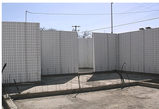
Figura 12 – Colocação de painéis no piso térreo
