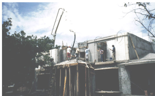
Figura 18 – Execução do piso
