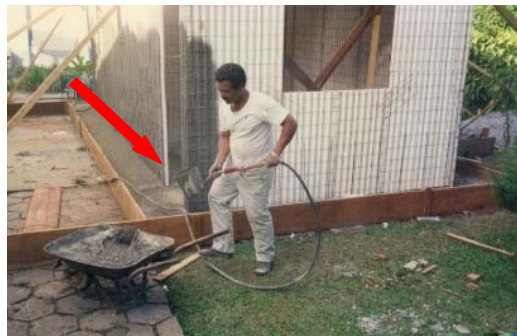
Figura 15 – Projecção da argamassa com equipamento adequado
