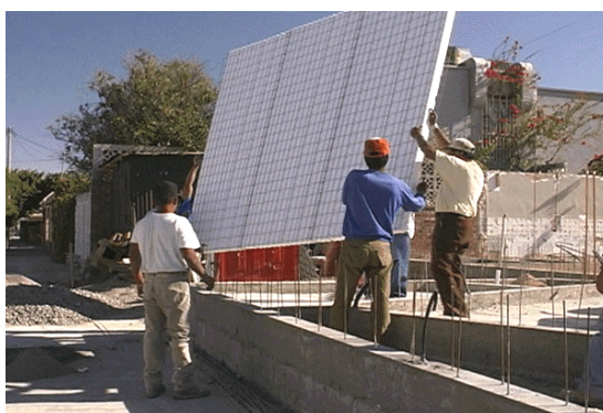
Figura 11 – Fixação de painéis
