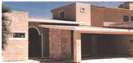
Figura 36 – Edifício residencial com vários tipos de acabamento dos painéis
