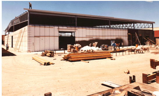
Figura 35 – Edifício industrial com painéis de fachada Monolite
