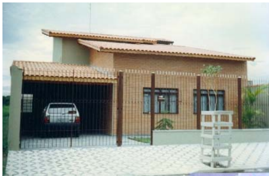
Figura 33 – Obra acabada com revestimento de tijolo na fachada
