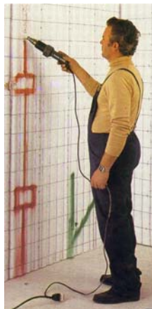
Figura 13 – Marcação e abertura de roços para instalações
