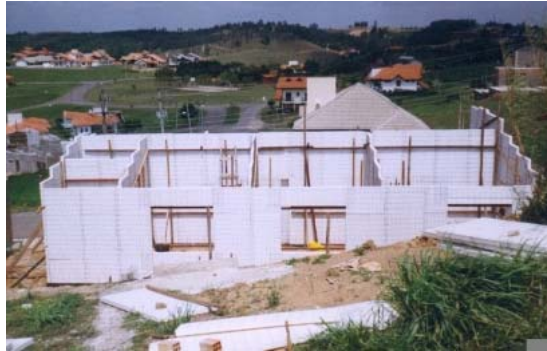
Figura 31- Obra em fase de montagem, antes de aplicação da argamassa. Lajes inclinadas apoiadas directamente sobre o painel, não utilizando madeiramento de cobertura, as telhas apoiadas directamente sobre a laje de cobertura.
