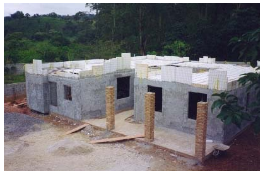
Figura 16 – Execução da laje do piso
