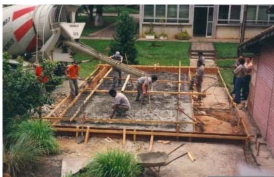
Figura 10 – Início da construção
