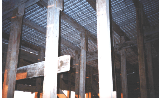
Figura 17 – Escoramento de lajes do sistema Monolite
