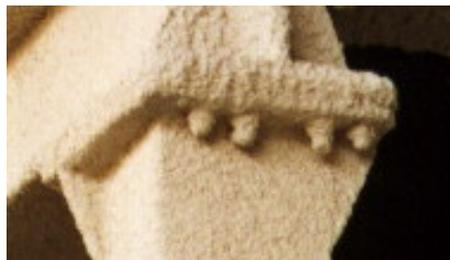
Figura 5 - Rebocos com argamassas acompanhando o contorno do perfil
