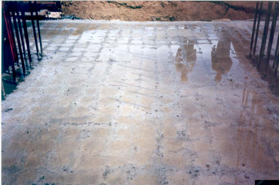
Assentamento do betão
