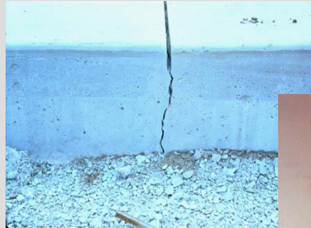
Juntas com espaçamento adequado
