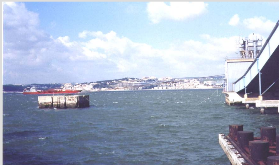
Colapso súbito da estrutura
