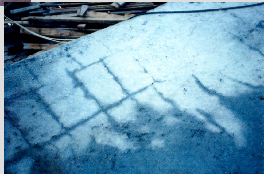
Malha de armaduras marcada na superfície
