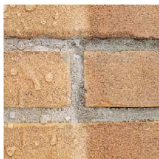
Figura 33 - Diferença entre a mesma superfície tratada/não tratada com hidrófugo
