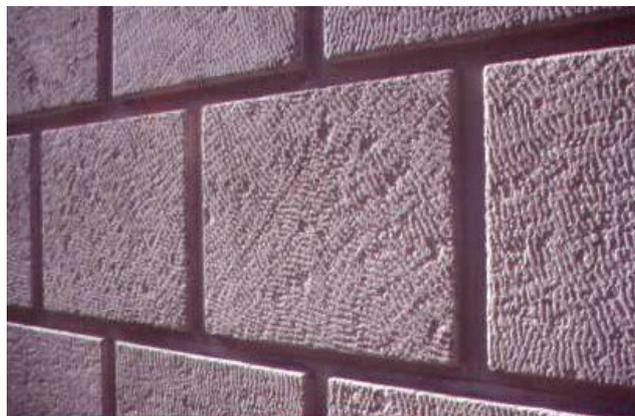
**Figura 26 - Aplicação de calcário branco no revestimento de uma parede exterior com acabamento gastejado <sup>a</sup>.**
