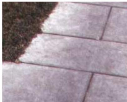
**Figura 28 – Revestimento de pavimento exterior com placas de granito cinzento com acabamento bujardado <sup>a</sup>.**
