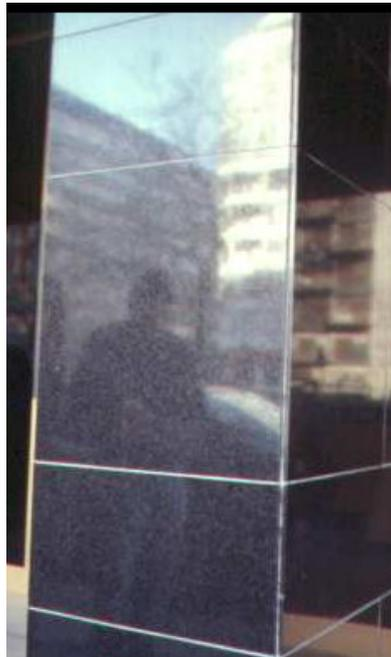
**Figura 27 – Aplicação de placas de granito cinzento com acabamento polido, no revestimento de um pilar de um edifício de habitação <sup>a</sup>.**
