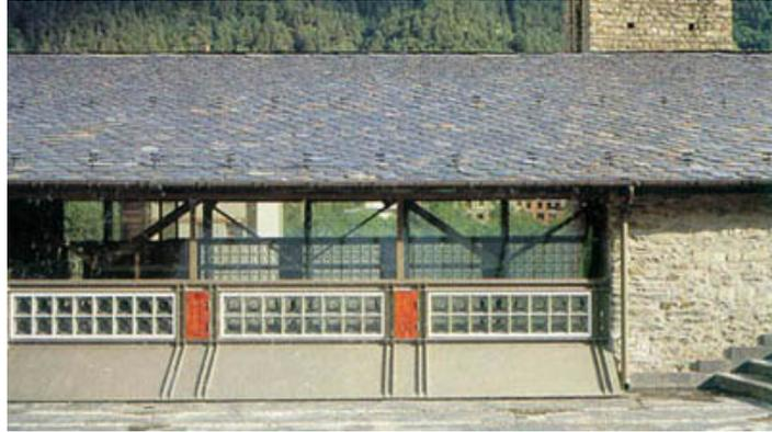
**Figura 25 - Revestimento de cobertura com soletos de ardósia.**
