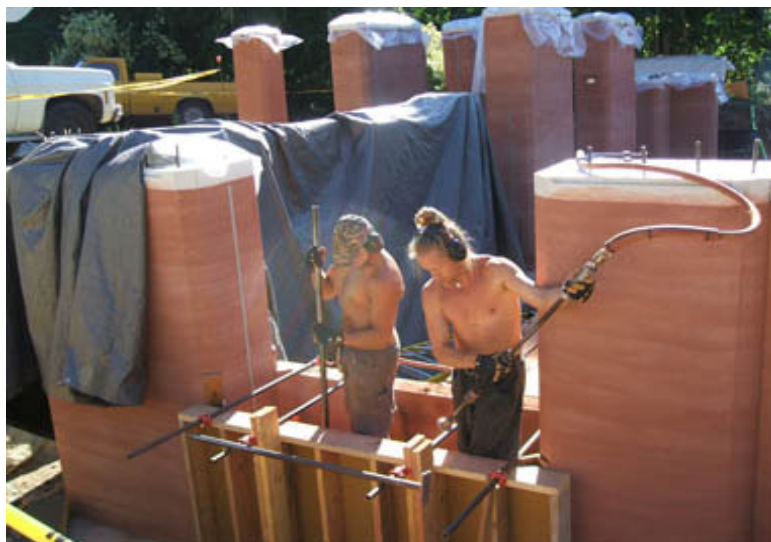
Figura 6 – Taipa com recurso a equipamento mecânico (processo actual).
