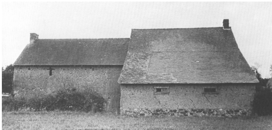
Figura 3 – Casa rural em terra crua, na Bretanha.
