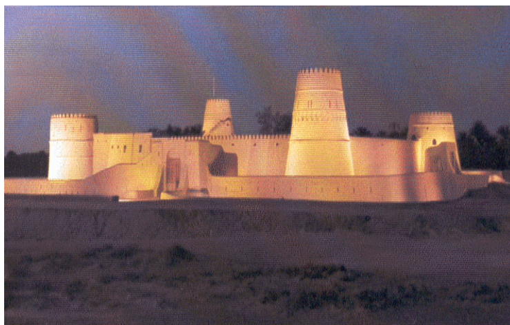
Figura 1 – Forte de Oman, em terra crua.
