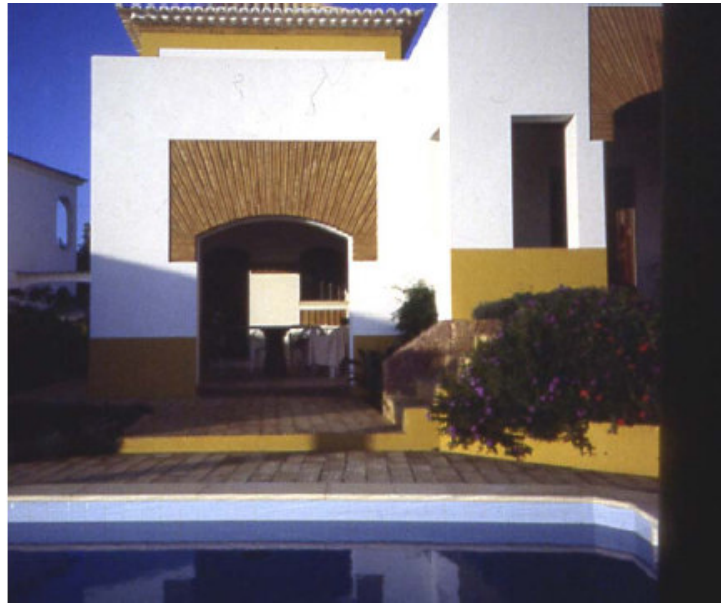
Figura 16 – Adobes prensados e estabilizados numa moradia em Vale da Parra (1999), autor Arqº. José Alberto Alegria 3 .
